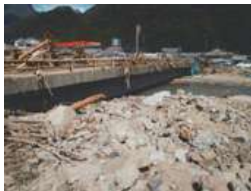
那智川における土砂・洪水氾濫状況。2011年9月4日未明、総雨量872mm、最大時間雨量123mm(和歌山県 市野々雨量観測所)で那智川の複数の支川で土石流が相次いで発生(近畿地整撮影)
