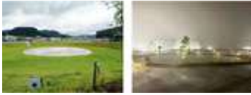
左写真は公園内の貯水池。右:今夏、8月10日夜9時ごろの大雨の様子。一定量雨水が貯まると貯水池として機能し、排水する仕組み(画像クリックで拡大表示/以下同様)
