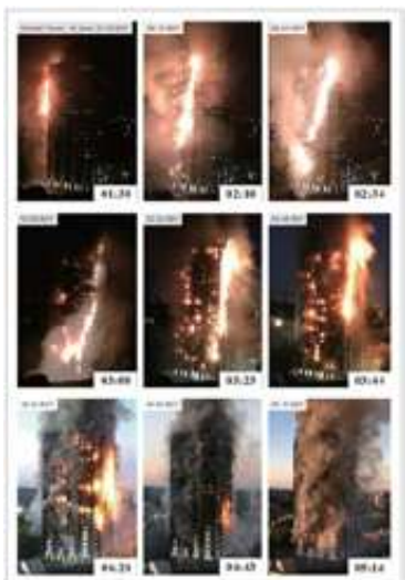
グレンフェルタワー火災の外壁面延焼の様子(関澤 愛「近年における高層建物火災頻発の背景と問題点」より)
