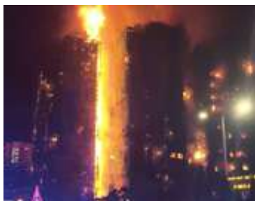
炎上する高層集合住宅の間が“煙突状態”をもち、炎の柱が立ち上がった(Wikipediaより)
