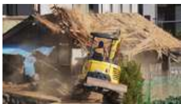
空き家解体作業（『Bosai Plus』2023年6月15日号より） （画像クリックで拡大表示／以下同様）
