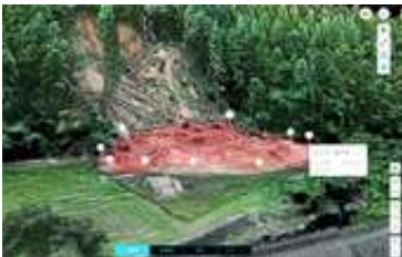
レーザースキャナを搭載したドローンを使用し、短時間で崩落現場の土砂体積量を測量、森林部の地面状況などの把握もできた(DBA資料より)
